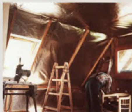
Obr. 6 – Zateplení střešní konstrukce RTI + aplikace hliníkové parozábrany.
