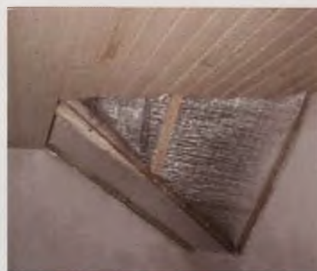
Obr. 9 – Použití RTI jako „integrovaná izolace a parozábrana“.
