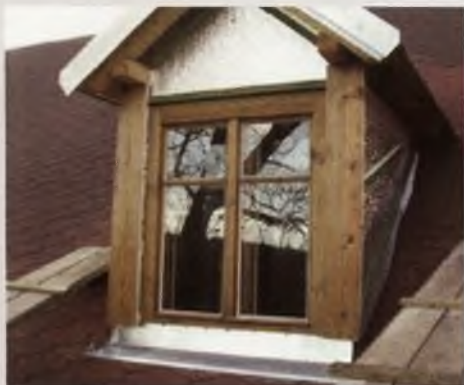
Obr. 4 – Zateplování problematických zón s rizikovými tepelnými mosty.
