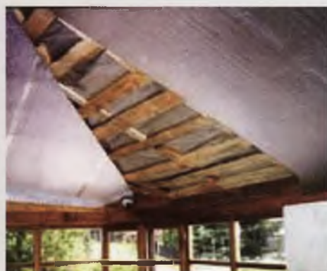
Obr. 10 – Rošt z odpadových prken sloužící jako dílační a kotvicí prvek.
