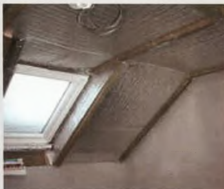
Obr. 5 – Použití RTI v podkrovní části konstrukce sloužící jako izolace a parozábrana.
