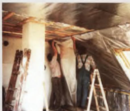
Obr. 8 – Příklad umístění RTI v ostění podkrovního okna.
