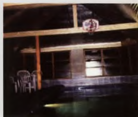
Obr. 12 – Aplikace RTI ve střešní dřevokonstrukci vystavené zvýšenému vlhkostnímu režimu.
