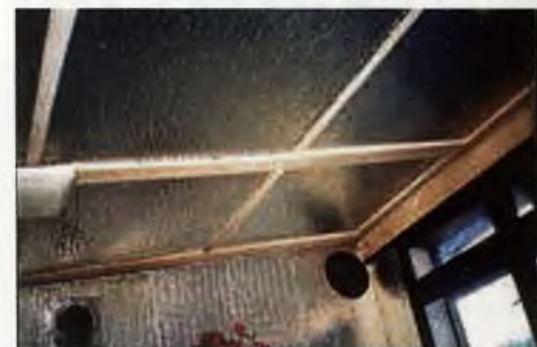
Aplikace RTI v celé konstrukci objektu.
