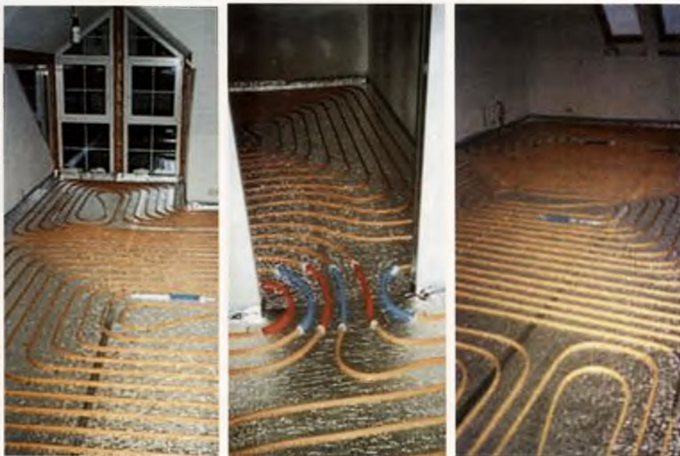
Detailní záběr na aplikaci teplovodního potrubí s využitím reflexní odrazové plochy RTI – Haasová–Menhart®, 2xAl KOMBI o tloušťce 8 mm.
