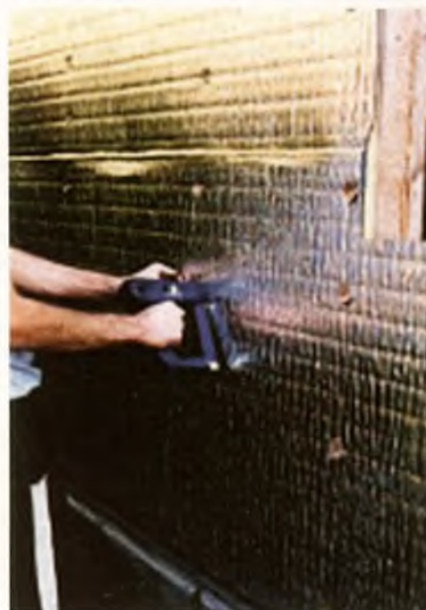
Aplikace RTI – Haasová–Menhart® v jednotlivých dřevokonstrukcích.
