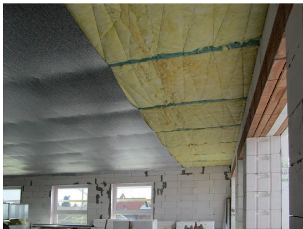
Stropní zateplení školky v Nehvizdech pomocí izolace RTI 2Al 8 mm se vzduchovou mezerou nad podhledem (foto Nekolný s.r.o.)
