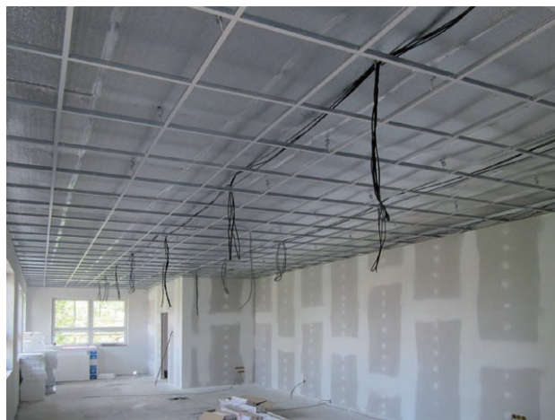
Stropní zateplení školky v Nehvizdech pomocí izolace RTI 2Al 8 mm se vzduchovou mezerou nad podhledem (foto Nekolný s.r.o.)
