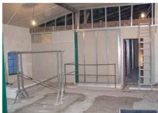
Obr. 13 Aplikace RTI pod sádkartonovým systémem Knauf.
