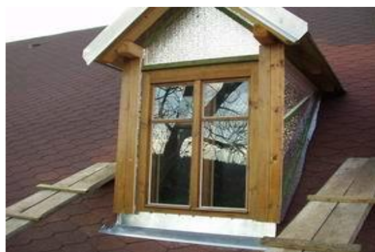
Obr. 9 Zateplování problematických zón s rizikovými tepelnými mosty.
