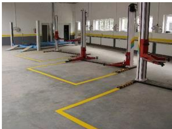
Obr. 6 Umístění RTI v pojezdové ploše lité podlahové konstrukce.
