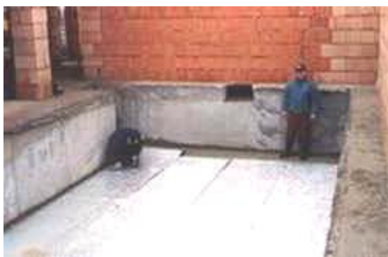
Obr. 8 Hydrotermoizolace bazénů, sklepů... Pomocí RTI.
