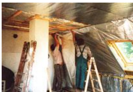
Obr. 12 Příklad konstrukce s trojí odrazivou vzduchovou dutinou.
