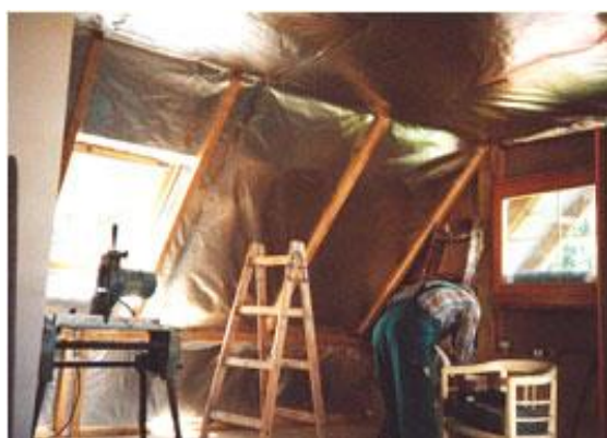
Obr. 10 Zateplení střešní konstrukce RTI + aplikace hliníkové parozábrany.
