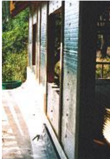
Obr. 14 –16 Připevňování RTI pomocí el. sponkovačky na dřevěný podklad. Na dalších obrázcích jsou patrné dilační prvky (latě, trámký) pro vytvoření vzduchové dutiny s odraz. plochami.
