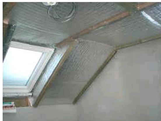
Obr. 7 Použití RTI v podkrovní části konstrukce sloužící jako izolace a parozábrana.
