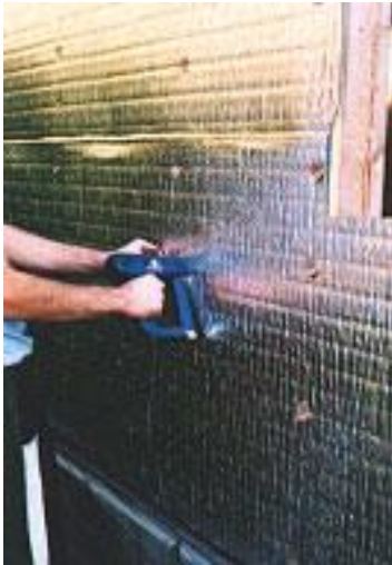
Obr. 14 –16 Připevňování RTI pomocí el. sponkovačky na dřevěný podklad. Na dalších obrázcích jsou patrné dilační prvky (latě, trámký) pro vytvoření vzduchové dutiny s odraz. plochami.
