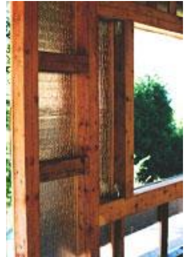
Obr. 14 –16 Připevňování RTI pomocí el. sponkovačky na dřevěný podklad. Na dalších obrázcích jsou patrné dilační prvky (latě, trámký) pro vytvoření vzduchové dutiny s odraz. plochami.
