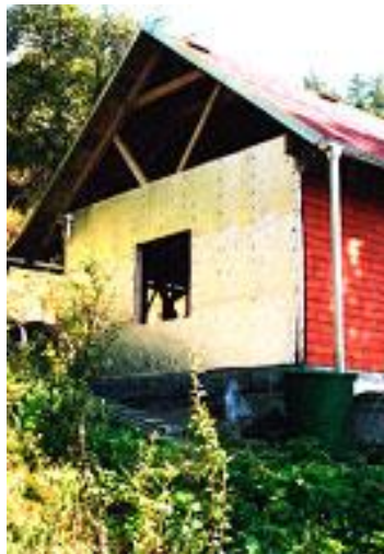
Obr. 15 –17 Umístění RTI v jednotlivých pohledech. RTI pásy jsou spojeny samolepicí pěnovou páskou.
