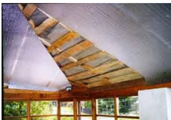
Obr. 17 Rošt z odpadových prken sloužící jako dilační a kotvící prvek.
