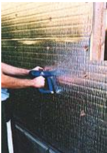
Obr. 11 – 14 Umístění RTI v jednotlivých pohledech. RTI pásy jsou spojeny samolepicí pěnovou páskou.
