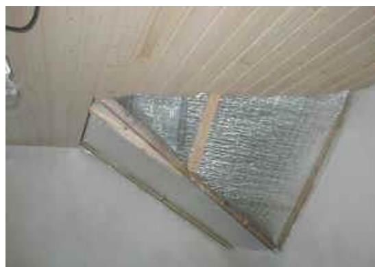
Obr. 10 Konstrukční detail s patrnou uzavřenou vzduchovou dutinou.
