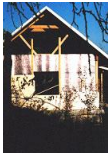
Obr. 11 – 14 Umístění RTI v jednotlivých pohledech. RTI pásy jsou spojeny samolepicí pěnovou páskou.
