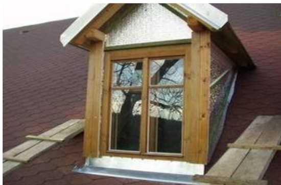
Obr. 5 Zateplování problematických zón s rizikovými tepelnými mosty.
