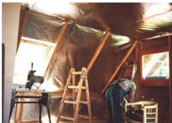
Obr. 7 Zateplení střešní konstrukce RTI + aplikace hliníkové parozábrany.
