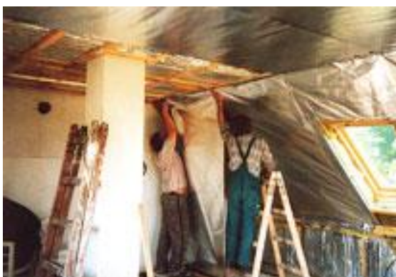
Obr. 9 Příklad konstrukce s trojí odrazivou vzduchovou dutinou.
