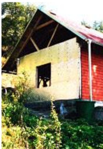
Obr. 11 – 14 Umístění RTI v jednotlivých pohledech. RTI pásy jsou spojeny samolepicí pěnovou páskou.
