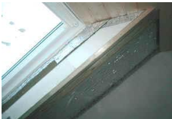
Obr. 15 Příklad umístění RTI v ostění podkrovního okna.
