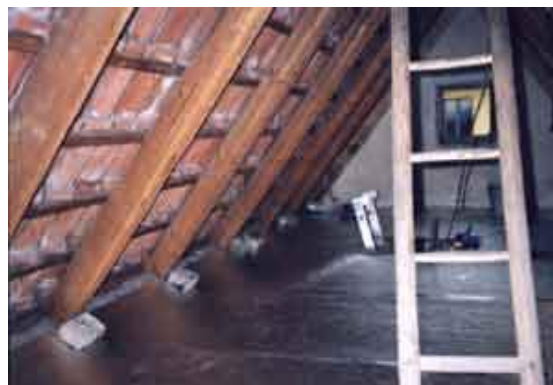
Obr. 16 Použití RTI jako „půdní izolační záklop“.
